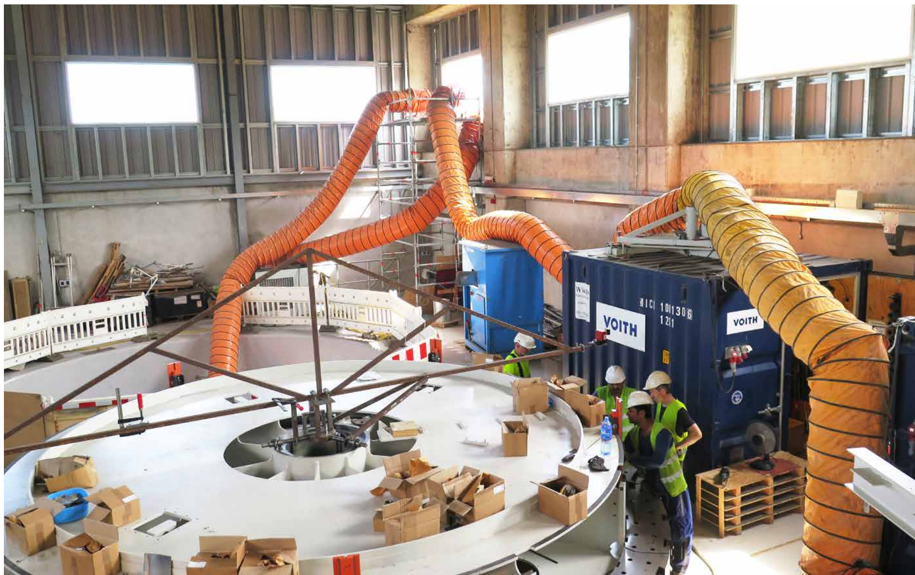
Den første turbinen er ferdig til å settes i drift. De tre andre gjøres klare. Foto: Jan Speed
