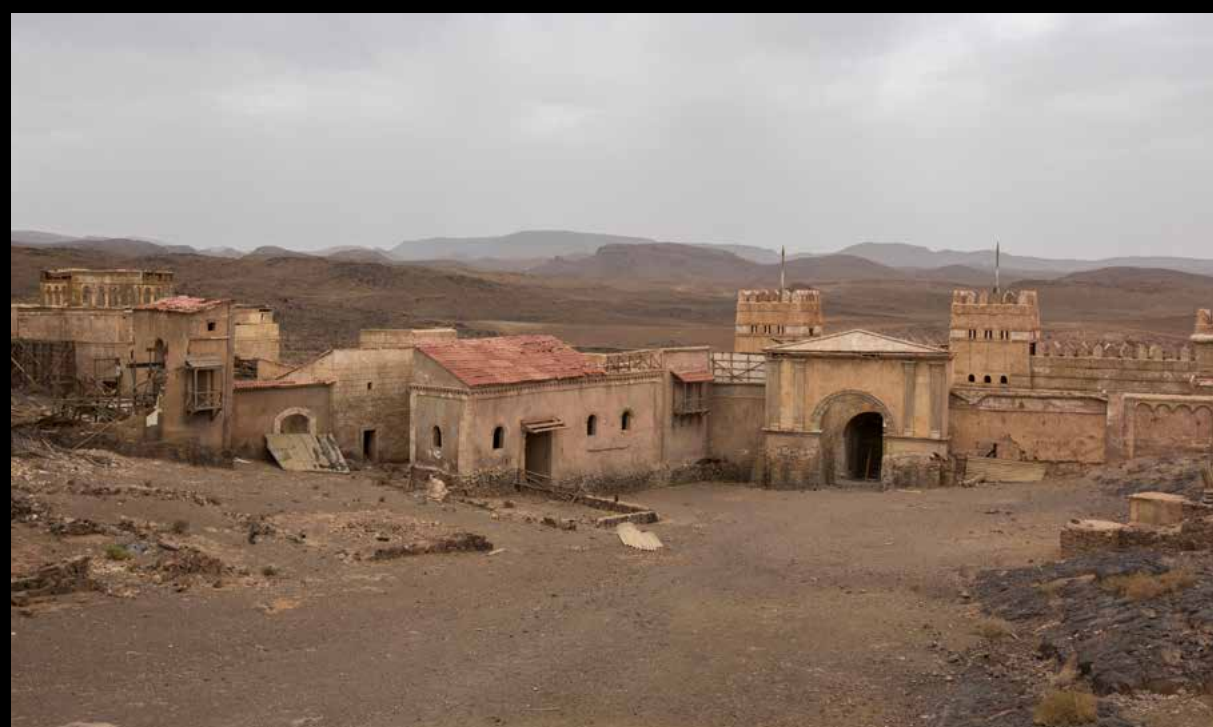
Dette forfalne bygningskomplekset ble bygget av et italiensk selskap i 1996. Det skal forestille Jerusalem og har tjent som kulisser for et dusin filmer med religiøst tema. Den siste var tv-filmen Killing Jesus fra 2015, produsert av National Geographic Channel.
