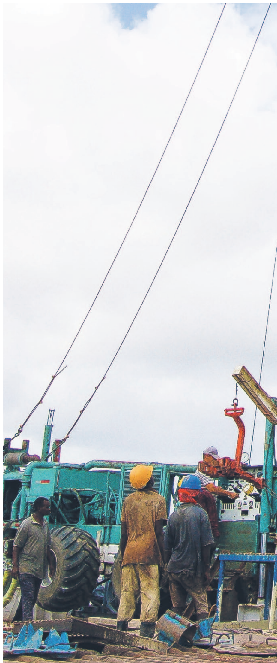
Prøveboring etter grunnvann utenfor Dar es Salaam i 2006. Arbeidet føres nå videre
