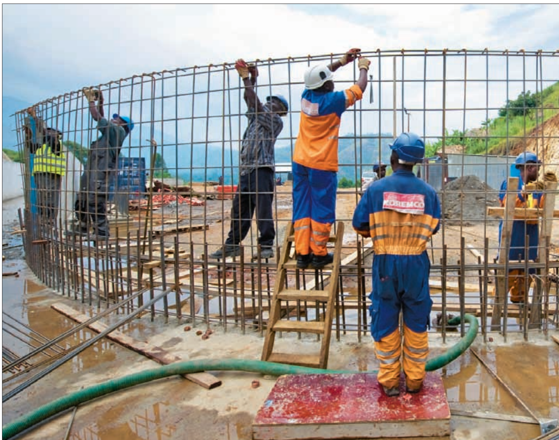
Rundt 500 mennesker har jobbet med å bygge kraftverket. I tillegg til TrønderEnergi har også firmaene ABB og Noremco deltatt i arbeidet.
