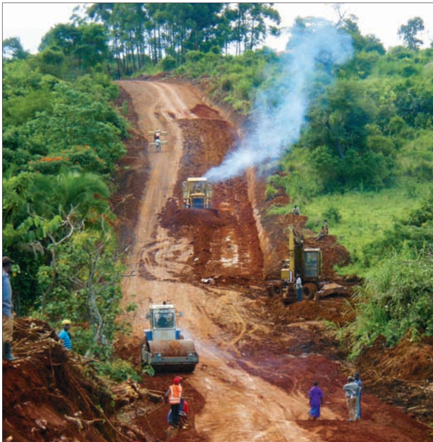
Oljeselskapet Tullow har allerede bygget en ny og bedre vei inn i naturreservatet der oljeaktiviteten foregår. På vei mot Kabwoya bygges det nå en bred asfaltvei som skal tåle tankbiltrafikken som snart kommer.
