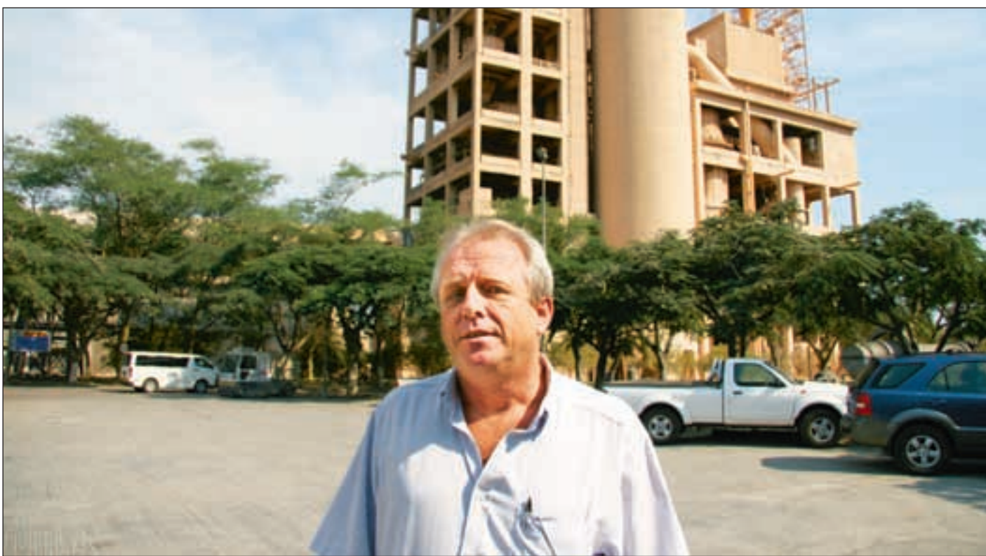
Miljøgevinsten for sementfabrikken er mindre CO 2 -utslipp og mindre kullstøv i luften. Dessuten er det enklere å fyre ovnen på gass enn på kull. Det gir mer stabilitet på ovnsdriften og mer kontroll over utslipp av støv. Steffen Kåsa er administrerende direktør i Cimentos de Mocimboa. FOTO: JAN SPEED
