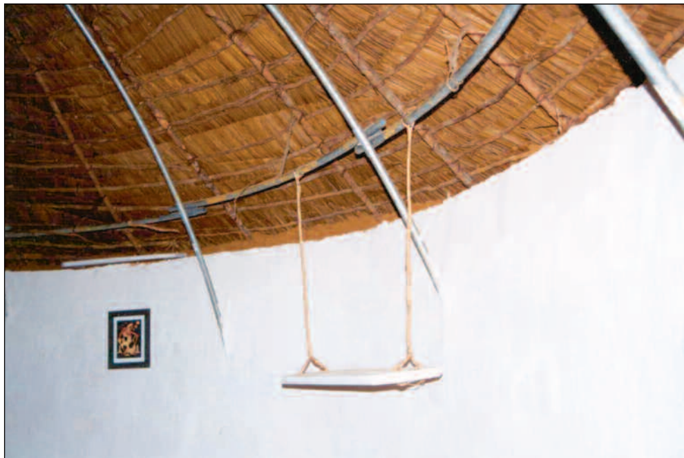
Ronda Forest Saver i bruk i Liberia. Tradisjonelle trekonstruksjoner erstattes av et metallrør. FOTO: PRIVAT
