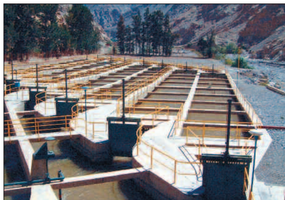
Dette sedimenteringsanlegget renser elvevannet før det tar veien inn i turbinene.
