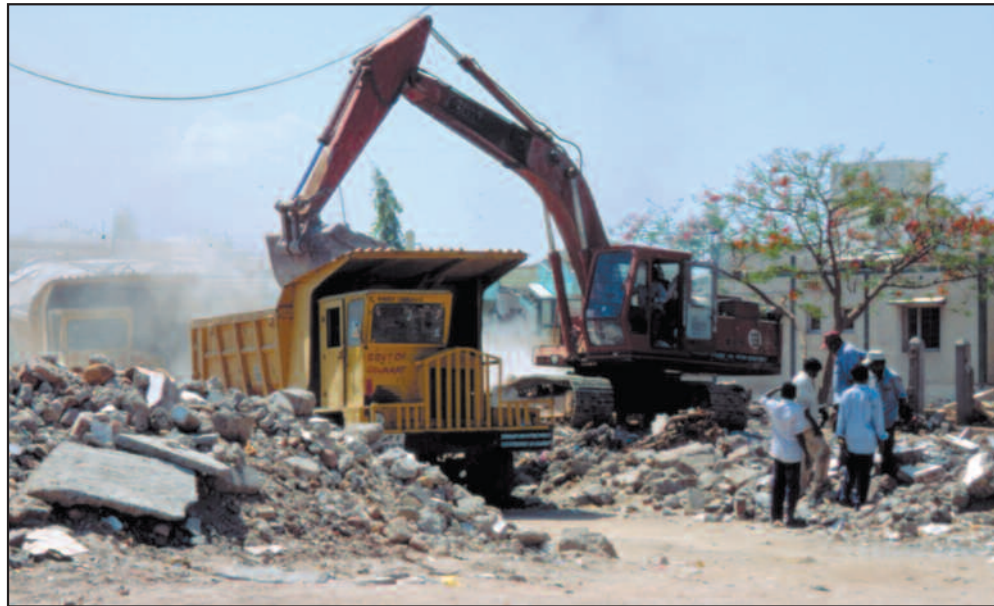
Fjerning av ruinene av det totalte raserte sentrumsområdet i småbyen Bachau, rett ved jordskjelvet episentrum, er blant oppgavene for delstatens tekniske etater.
