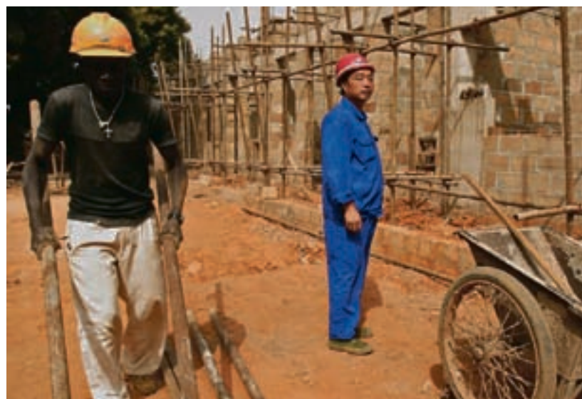
En kinesisk arbeidsleder styrer byggingen av en militærforlegning i Guinea Bissau som Kina har gitt i gave. FOTO: AP/SCANPIX
